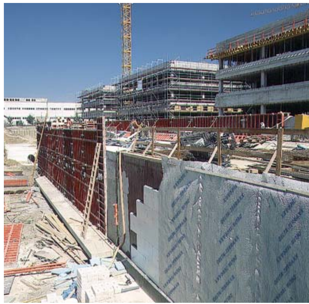
DELTA®-TERRAXX tegen wandisolatie biedt een maximum aan bescherming.
