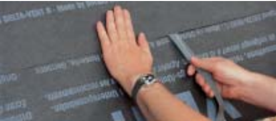
Winddichte verkleving met DELTA®-VENT S PLUS.
