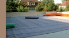
Drainage onder klinkers
