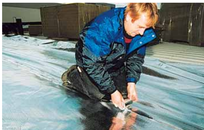
← Die Dampfsperre wurde auf dem Trapezblech lose verlegt, die Überlappungen mit einem Spezialband luftdicht verklebt.
