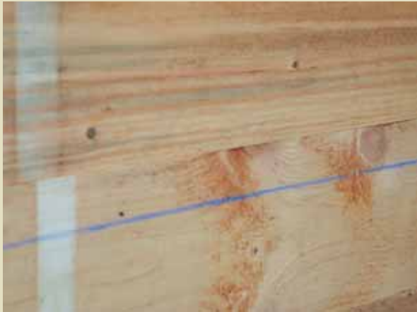
↑ Der erste Schnurschlag erfolgte in Bahnenbreite auf 1,50 Meter Höhe.
