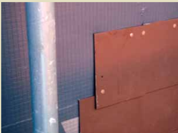
↑ Es folgte die Deckung mit Faserzementplatten im Format 20 x 20 cm. Die sehr engmaschige Gitterbedruckung im Raster 1 x 1 cm ermöglichte dabei eine genaue Ausrichtung.
