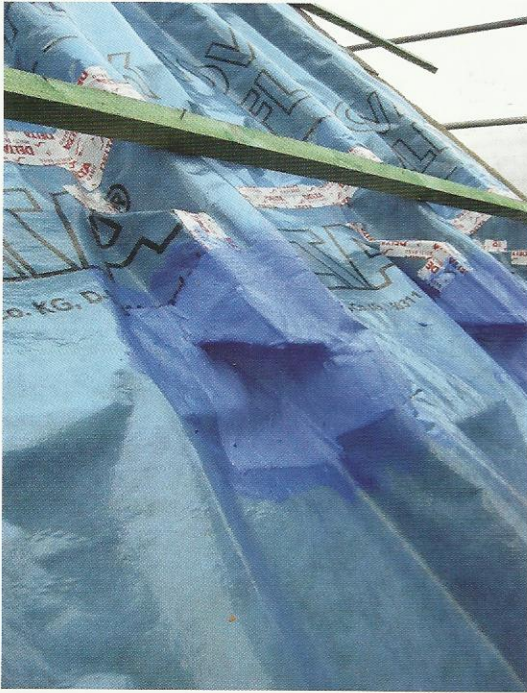
Besondere Anschlussdetails wie die Zangenköpfe wurden ebenfalls mit der flüssigen Variante eingedichtet.
