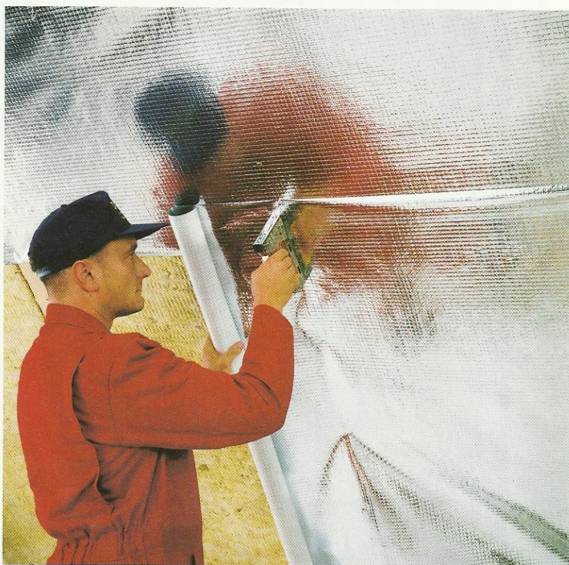
Besonders schnell lassen sich Bahnen mit Selbstkleberändern verkleben Foto: Dörken
