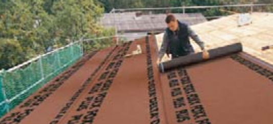
Die Verlegung erfolgt parallel zur Traufe.
