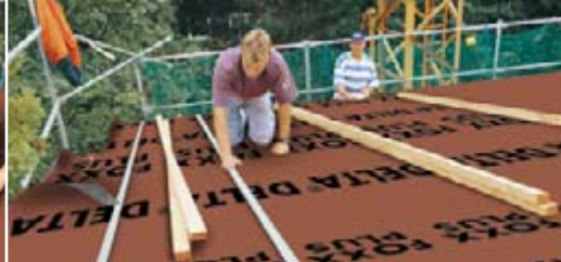
Abdichtung mit DELTA®-NAGELDICHUNGSBAND.
