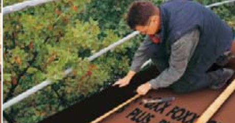
Die Bahn endet am Abschluss der Holzschalung.
