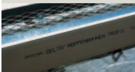
6. Putzabschlusschiene anbringen.
