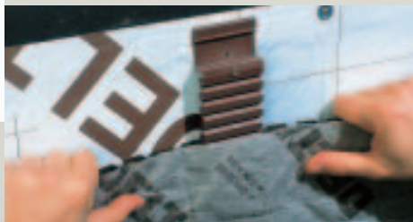
3. DELTA®-GEO-DRAIN unterschieben.
