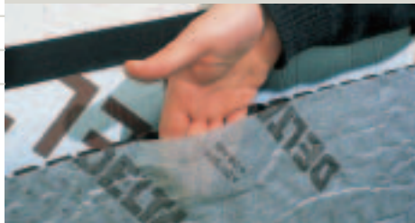
2. DELTA®-GEO-DRAIN Vlies lösen.
