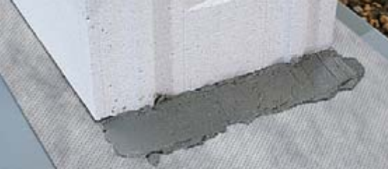
Seitlicher Überstand für Verbund mit Abdichtungsschichten.
