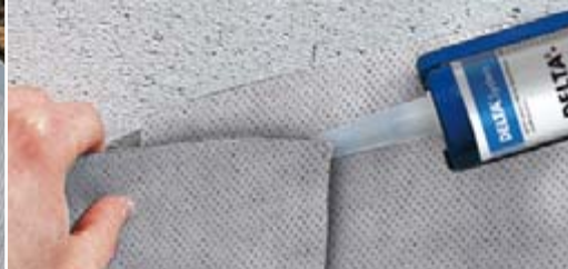
Verbindung der Bahnen mit DELTA®-THAN.
