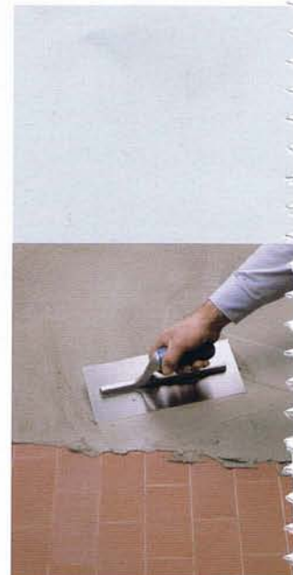
Posa in opera di malta cementizia bicomponente (Colmef).
