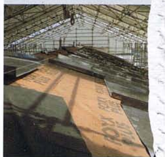
Opere di impermeabilizzazione della copertura del Duomo di Siena (Dörken).
