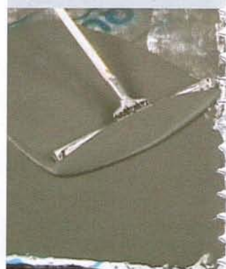
Sistema impermeabile bicomponente per balconi, terrazze e coperture piane (Acquascud di Volteco).
