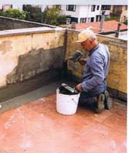
Idrofin 2K - Tecnologia ARE è un bicomponente formato da una polvere a base cementizia e da una parte liquida a base di polimeri resinosi; a basso spessore e maggiore resistenza ai raggi UV (Wellcom).
