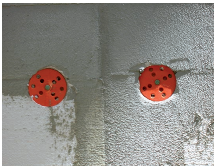
Per la coibentazione perimetrale del tipo "a cappotto" sono stati utilizzati anche dei tasselli di ancoraggio adesive
