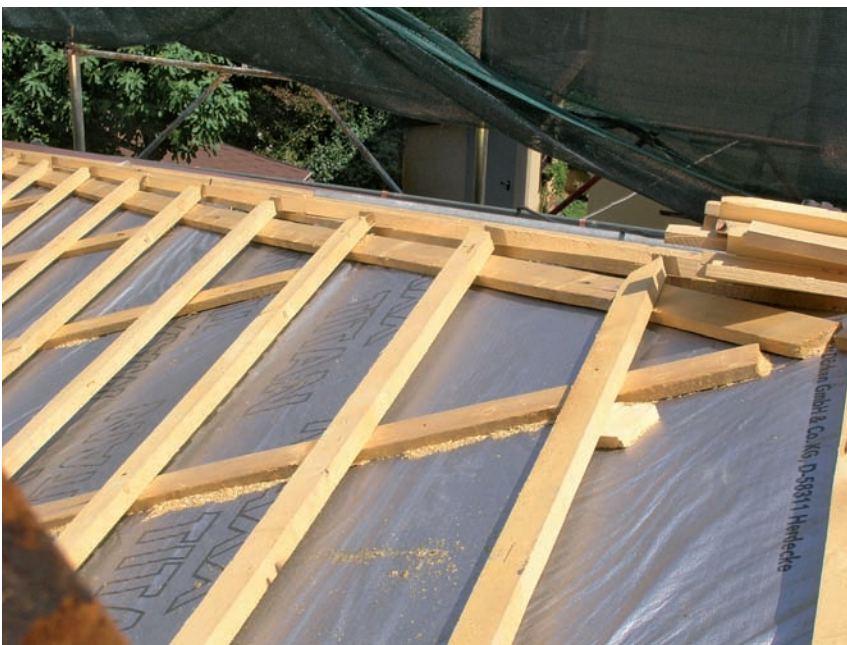
Posa della termomembrana traspirante e riflettente il calore
