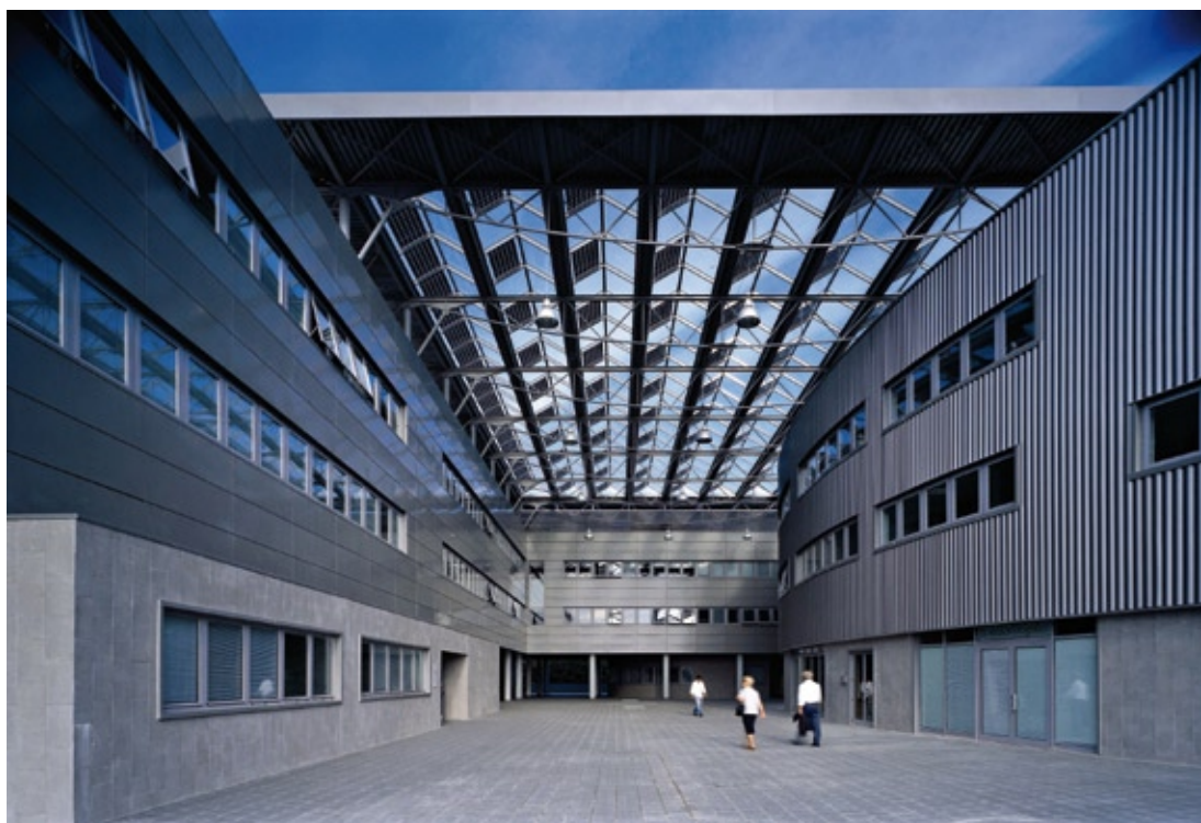
Nuova sede degli Uffici Comunali a Formigine. Copertura vetrata integrata con impianto fotovoltaico (cfr Modulo 343, pag. 716).
