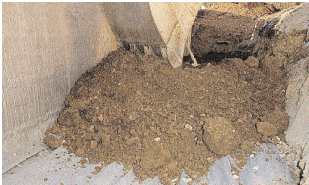
Sotto: grazie all'elevata resistenza alla compressione (150 kN/ m 2 ), la membrana alveolare DELTA-NP DRAIN protegge lo strato d'impermeabilizzazione da eventuali danni dovuti alle operazioni di rinterro
