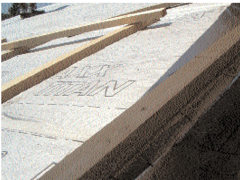
Sotto: il prodotto DELTA®- REFLEX PLUS posato sul tavolato di perline. Le sovrapposizioni sono sigillate ermeticamente grazie alla banda adesiva integrata
