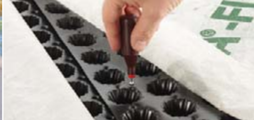
Con il punteruolo DELTA®-FLORAXX le membrane vengono perforate e fissate durante la fase di posa in opera.
