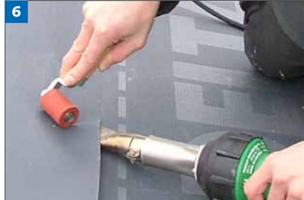
**(Bild 6) Nahtverschweißung mit Heißluft:**
