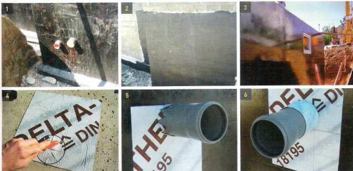
Rohrdurchgänge sind potentielle Schwachstellen der Kellerabdichtung und müssen sorgfältig geplant und ausgeführt werden
