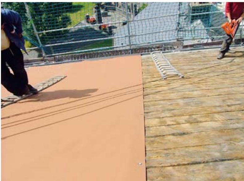
**Die Verlegung der Bahnen kann auch vom First zur Traufe erfolgen. Bei hoher Wetterbeanspruchung ist es sinnvoll, die Überdeckung zu verkleben.**
