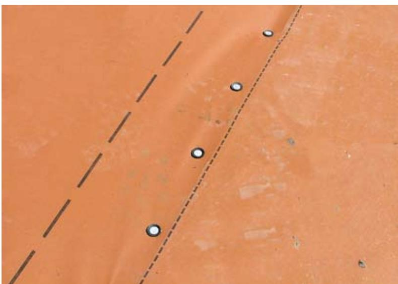
**Spezielle Pappnägeln mit abdichtender Gummischeibe sind ein sicherer Schutz gegen ein „abgesoffenes“ Dach.**
