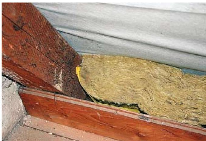
**Hohlkehlen, die wie Luftströmungskanäle wirken, können zu einem erhöhten Tauwasserausfall führen. Gleichzeitig schiebt sich die Wärmedämmung – wie gut zu sehen – nach oben und gelangt in die Belüftungsebene der Konterlatten.**
