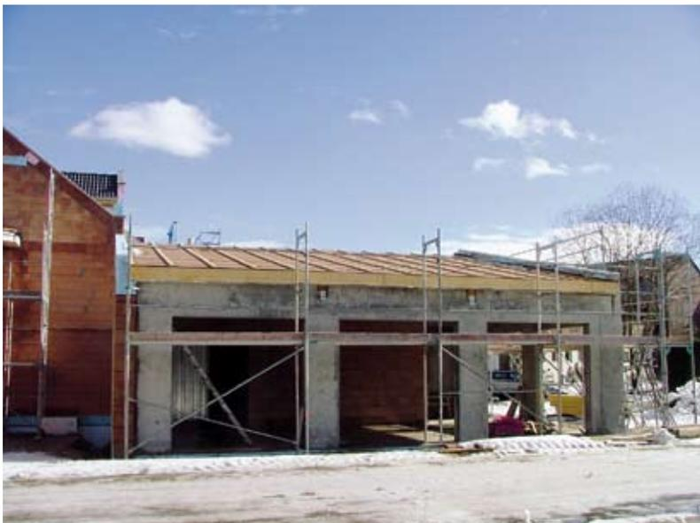
**Bis der Schnee endgültig taut, wird die Oberseite der Dachfläche – in diesem Fall eine Unterdeckung – auf näherungsweise null Grad Celsius gehalten. Auf der kalten Innenseite kann sich dadurch schon tagsüber die Feuchtigkeit aus der wärmeren Raumluft niederschlagen.**
