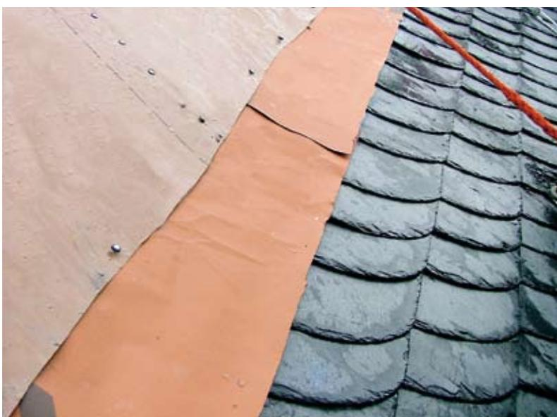
**Das Abfangen von Niederschlägen bei Arbeitspausen durch einen sogenannten Schleppstreifen sollte eine Selbstverständlichkeit sein.**
