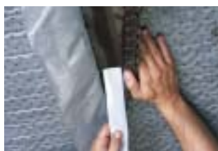
Integrovaný samolepicí okraj pro precizní pokládku
