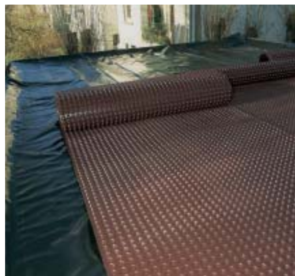
DELTA®-MS 20 perforovaná slouží jako hydroakumulační vrstva a odvádí přebytečnou vodu.
