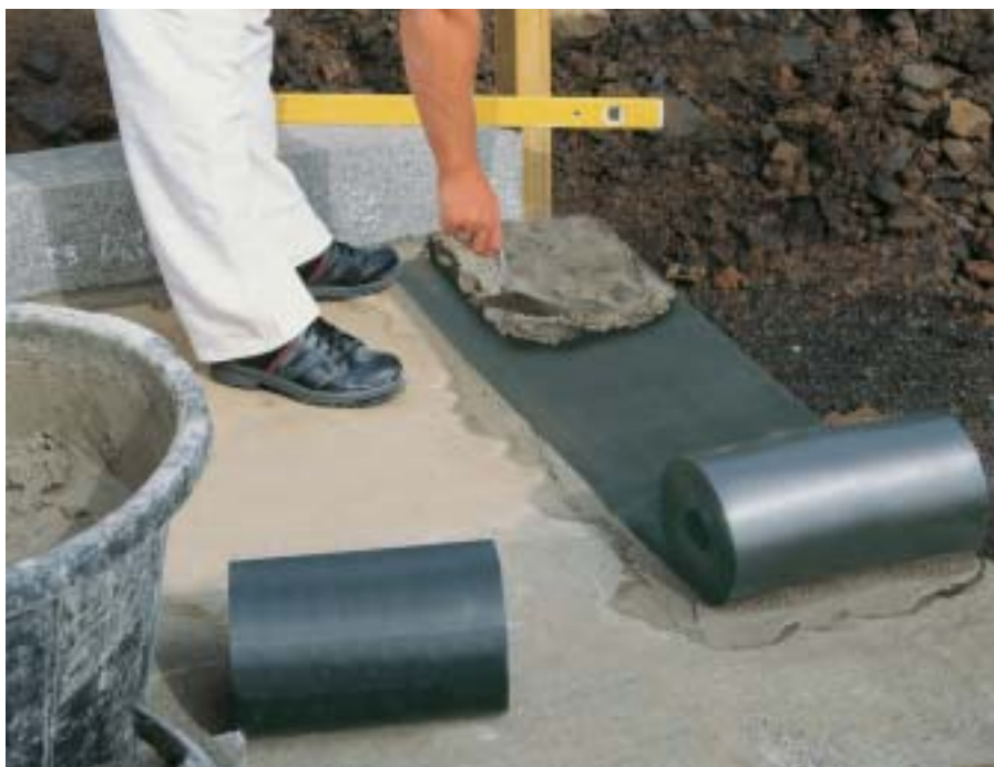
DELTA®-PVC-Protivlhkostní zábrana se spolehlivě přizpůsobí všem nerovnostem v podkladu.
