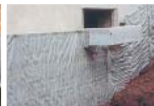
DELTA®-DRAIN udržuje spodní stavbu suchou a působí jako dodatečná tepelná izolace
