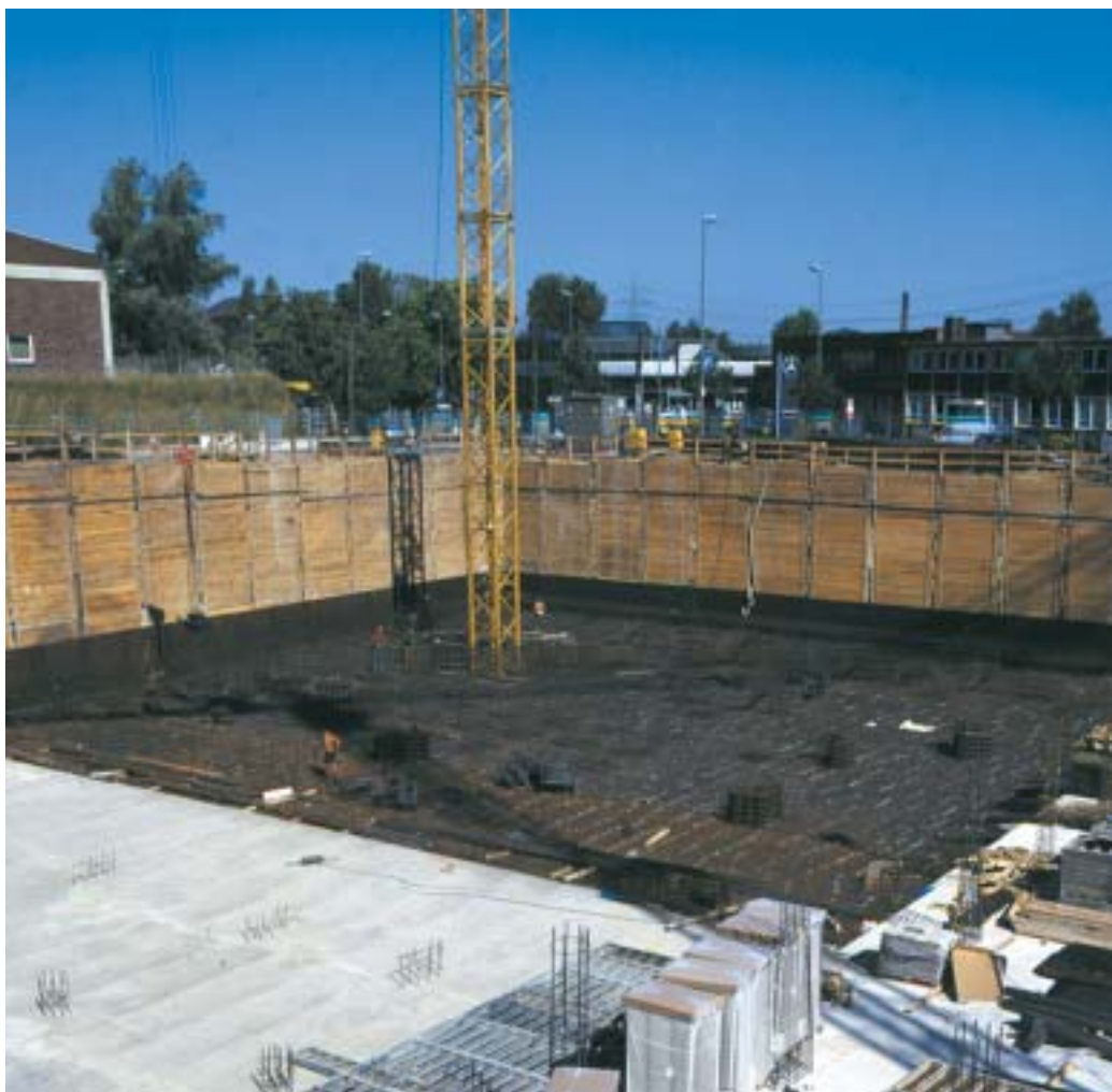
DELTA®-TERRAXX dvouvrstvý kompaktní pás se pokládá rychle a v jediném pracovním kroku.
