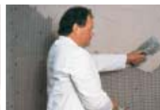
Omítka se jednoduše natahuje hladítkem
