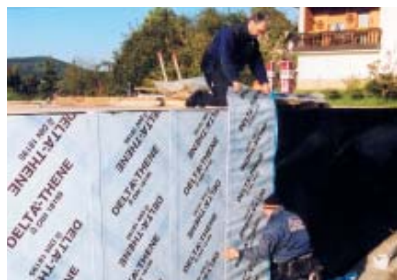
DELTA ® -THENE se jednoduše „tapetuje“.
